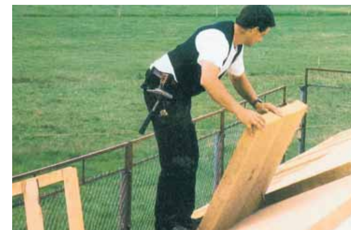
24 Aufsparrendämmssystem (Natur-Baustoffbuch)
