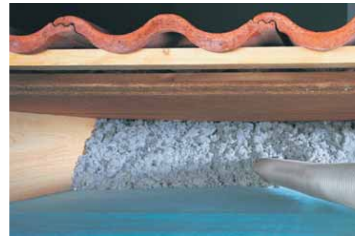
22 Einblasen von Zellulosedämmstoff
