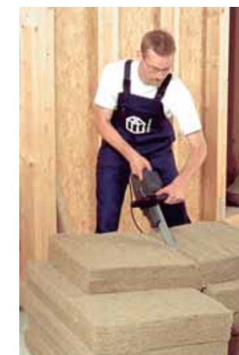
27 Zuschnitt von Flachsdämmmatten (Flachshaus)
