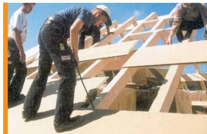
26 Aufsparren- dämmsystem (Natur-Baustoffbuch)
