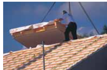
Setzen eines wärmeisolierten Dachelementes
