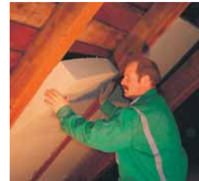
Dachdämmung mit Zelluloseplatten
