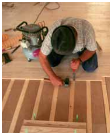
Verlegung von Nagelparkett auf Unterkonstruktion
