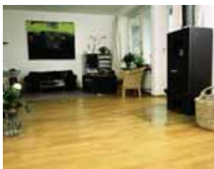
Hölzer geringer Resistenzklasse wie Buche oder Ahorn sind sehr gut im Innenbereich, z. B. als Fußbodenbelag, geeignet.
