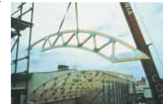
Für die Entwicklung zu immer leichteren, materialsparenderen Holzkonstruktionen stehen Stegträger und Fachwerkträger.
