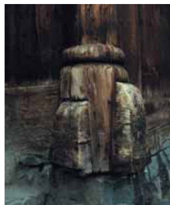
Sockeldetail einer Stabkirche: Im Spritzwasserbereich besteht der Sockel aus Stein – erst oberhalb beginnt die Holzkonstruktion.
