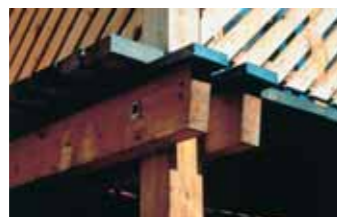
Schutz eines Holzträgers mit einer Abdeckung.
