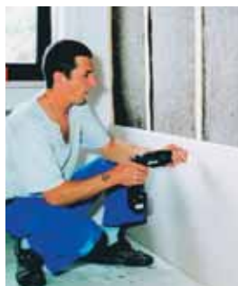
Sanierung mit Schafwollvlies
