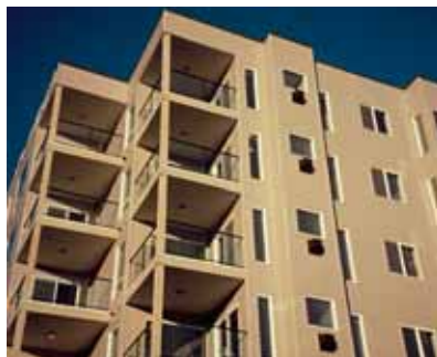
In Nordamerika gehören selbst sechsstöckige Wohnhäuser in Holzrahmenbauweise längst zum Alltag
