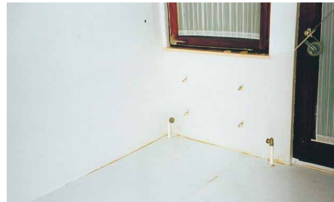
2 Schadstoffsanierung nach einer Untersuchung: Absperrtapeten für Holzschutzmittel, Formaldehyd usw. (Quelle: ÖBZ – Schulungsfolien, 2002)
