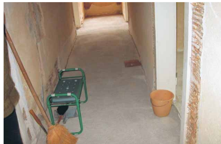
10 Sanierung eines schadstoffbelasteten Estrich- und Putzbelags – Zusammenarbeit zwischen Umweltmedizin und Innenraumanalysen (Quelle: ÖBZ – Schulungsfolien, 2002)
