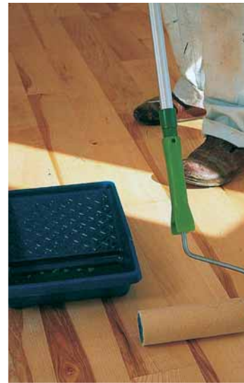
15 Das Ölen eines Holzfußbodens (BIOFA)
