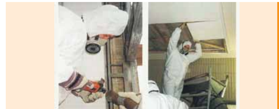
31 Sanierung einer PCB-Belastung (Zwiener, 1997)
